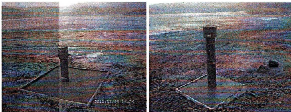
Сл. 10, 11. Опремување на устието на пиезометрите,и инклинометрите со бетонско столбче, метален капак и катанец
