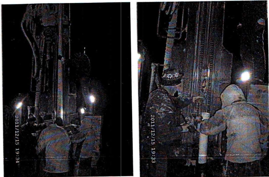
Сл. 5, 6. Вградување на инклинометриите
