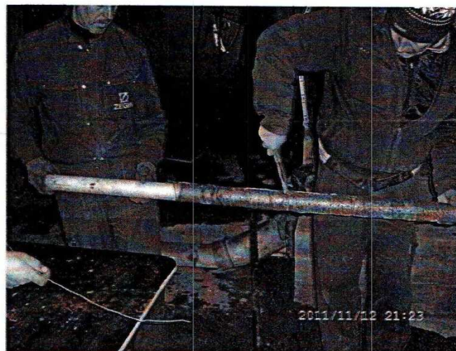
Сл. 5. Пакување на филтриите од ѓесок 1-3mm, ПВЦ мрежа 0,5mm и поцинкована жица
